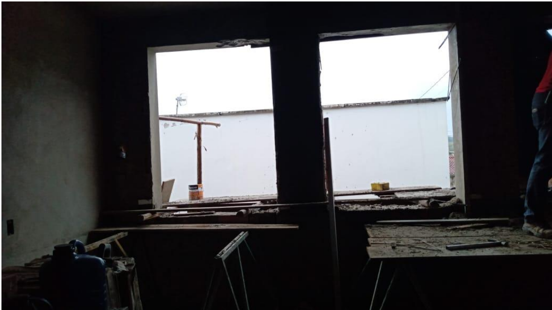
1 Requadro para colocação de vidro
