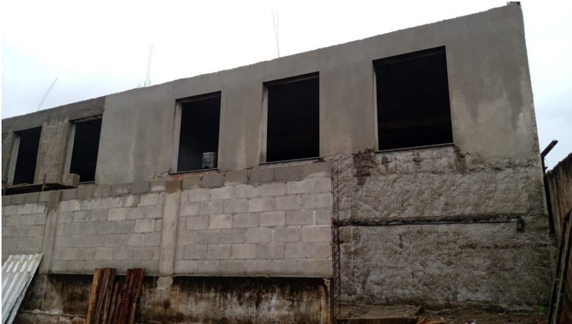
5 Reboco Parte externa e requadro de janelas
