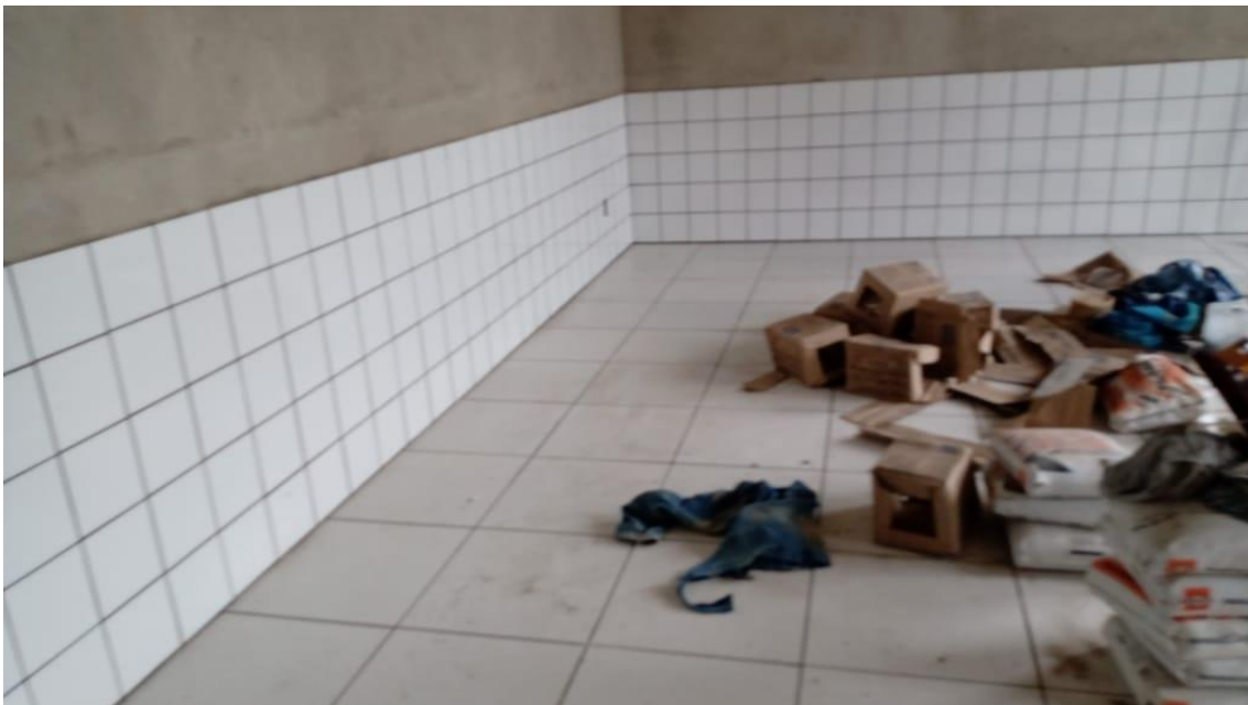
6 Colocação de Azulejos
