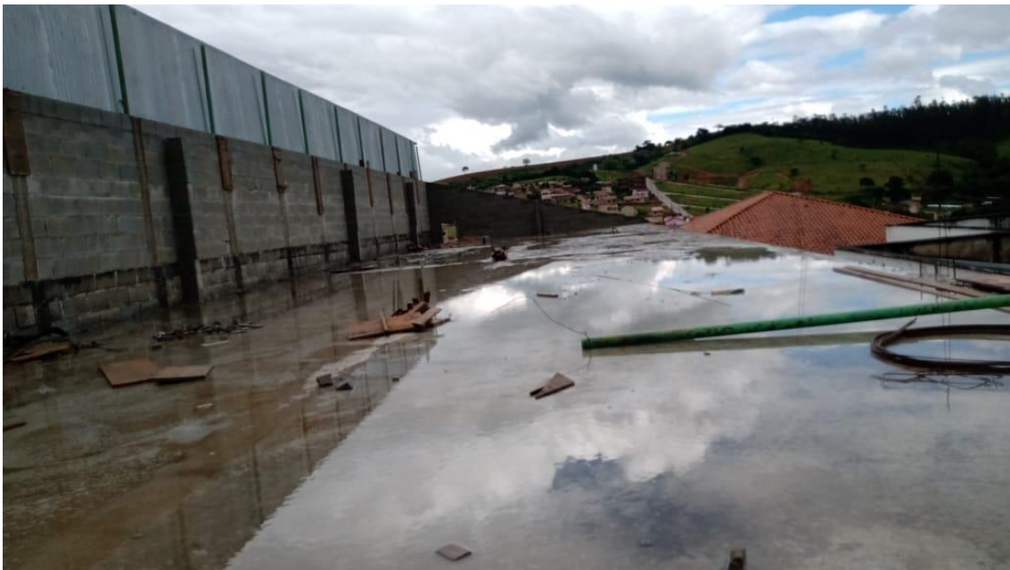
4 Laje concretada
